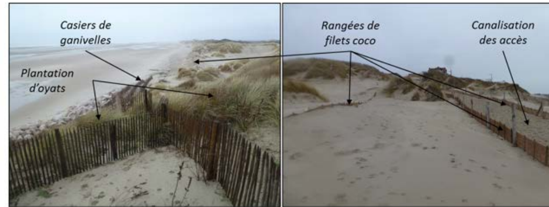
Figure 54. Technique de gestion douce des dunes actuellement en place au Nord de Merlimont
