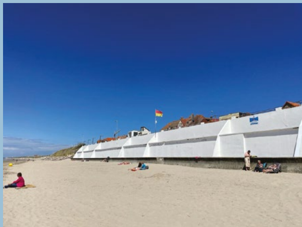
Remise en peinture du perré
