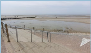
Réfection et réouverture de l'escalier situé au sud de la digue
