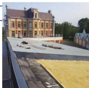
La toiture de l'école a été entièrement renouvelée. Ce chantier d'envergure a permis d'isoler et de changer toute la couverture de la toiture.
