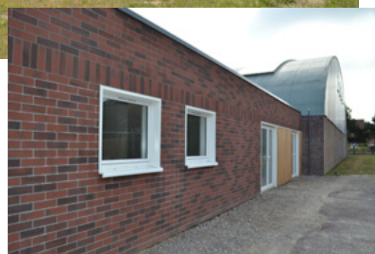
La nouvelle façade de la salle polyvalente est composée d'un bardage en bois et de briquettes.
