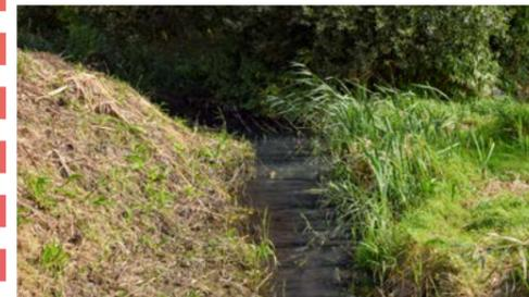
Certaines propriétés privées de Merlimont, sont traversées par des fossés. Ces derniers permettent l'écoulement naturel des eaux pluviales, évitant ainsi les inondations. Ce réseau de fossés se déverse ensuite dans le cours d'eau de la Grande Tringue.
