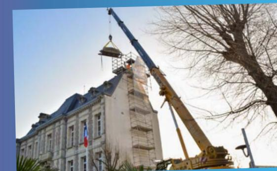
Les travaux de sécurisation de la mairie sont terminés. Les clés de voûte ont été remises en état, la cheminée changée, la façade arrière hydrofugée et un enduit intérieur a été réalisé sur les pignons.
